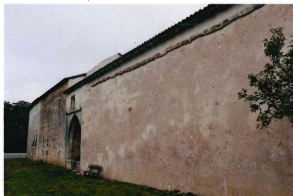
Figure 7 - Façade sud du château.
