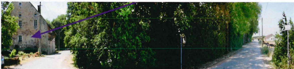
Figure 10 – Vue sur l'ancien Moulin
