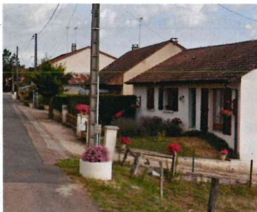
Figure 10 - Vue des avants aménagés route d'Houéville.
