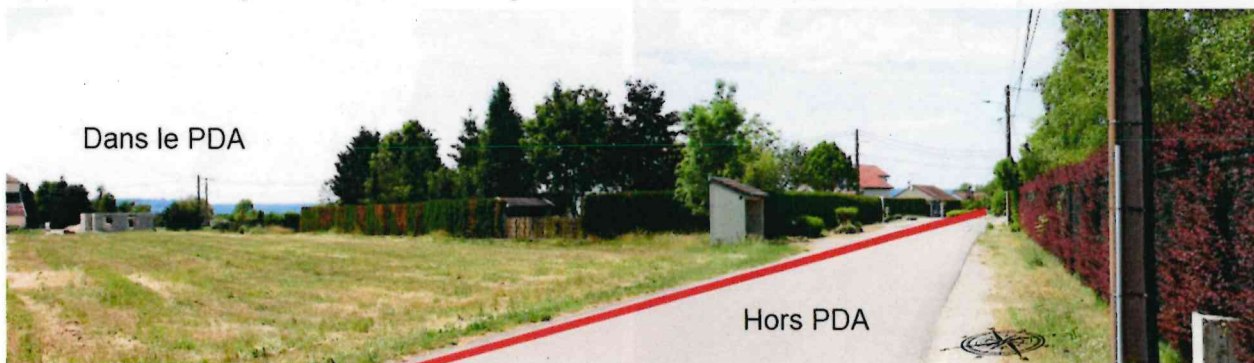
Figure 10 - Rue du Villon, dans le secteur pavillonnaire
