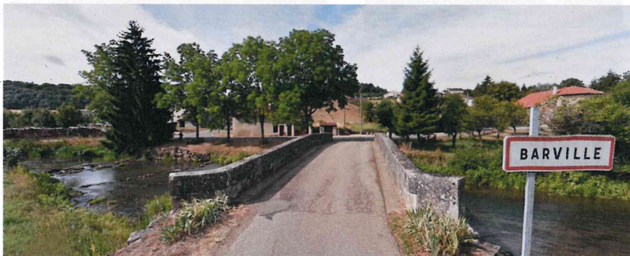
Figure 7 - Vue de l'entrée du village côté Vair
