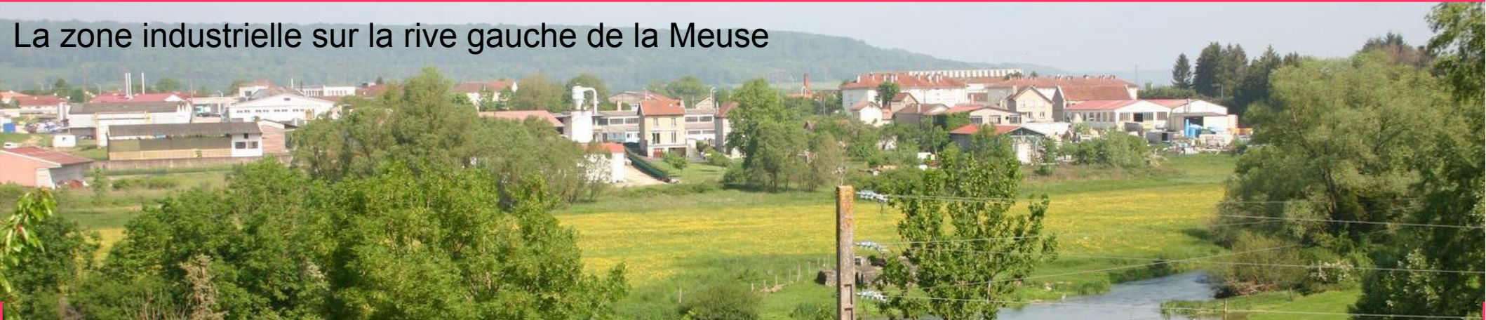
Les villas liées à l'industrie sur la rive gauche de la Meuse
