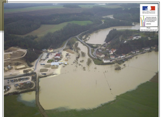
Photo aérienne de la crue du Vair le 17 décembre 2011 Barville - Harchéchamp
